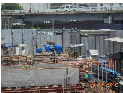
รูปที่ 3 รั้ว Steel Sheet รอบแนวเขตพื้นที่ก่อสร้าง
