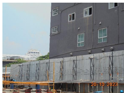
รูปที่ 3 รั้ว Steel Sheet รอบแนวเขตพื้นที่ก่อสร้าง
