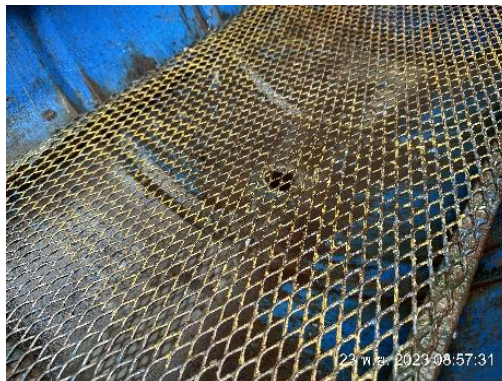
รูปที่ 18 ตะแกรงดักขยะก่อนระบายลงสู่ท่อระบายน้ำสาธารณะ
